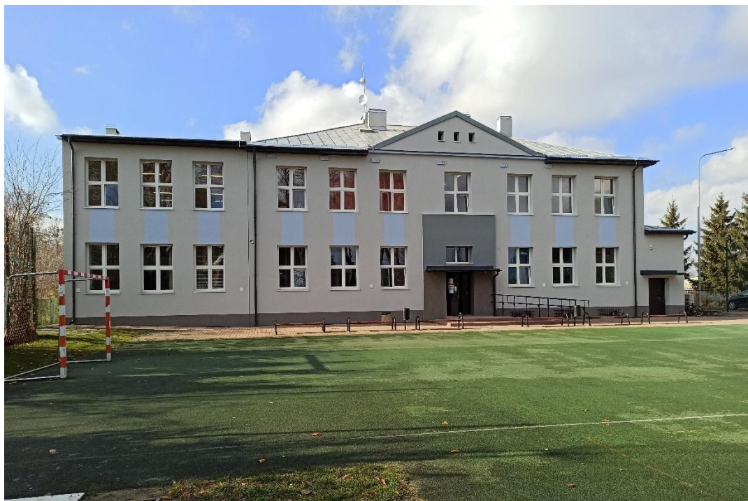
Budynek Szkoły Podstawowej w Pawłowie po termomodernizacji
