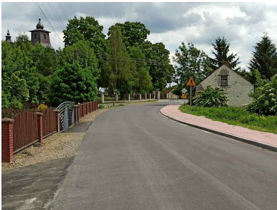
Kanie, przebudowana droga gminna
