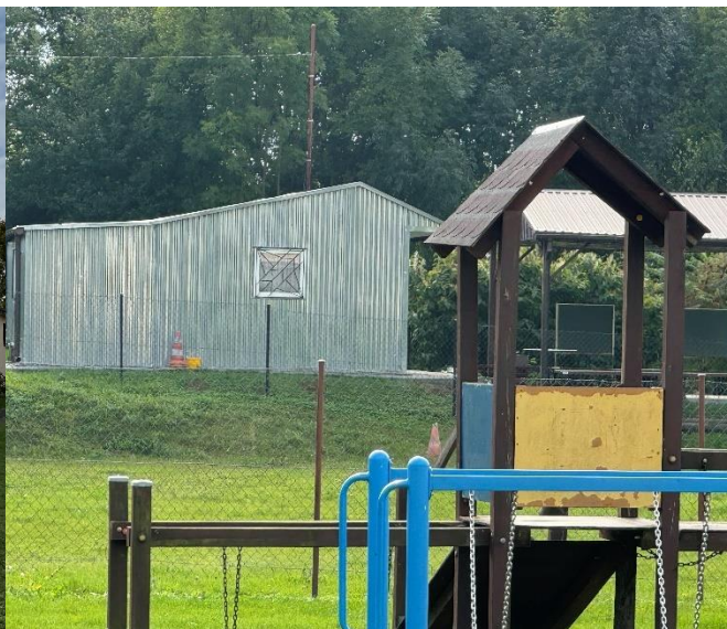
Rysunek 16. Blaszany budynek obecnej świetlicy wiejskiej w Krasnem – bardzo niska funkcjonalność obiektu.
